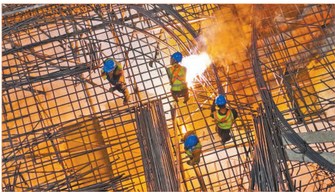
甘肃张掖盘道山抽水蓄能电站建设现场,建设者们正在进行主厂房发电机座钢筋骨架捆扎。 王 将 摄(人民视觉)
