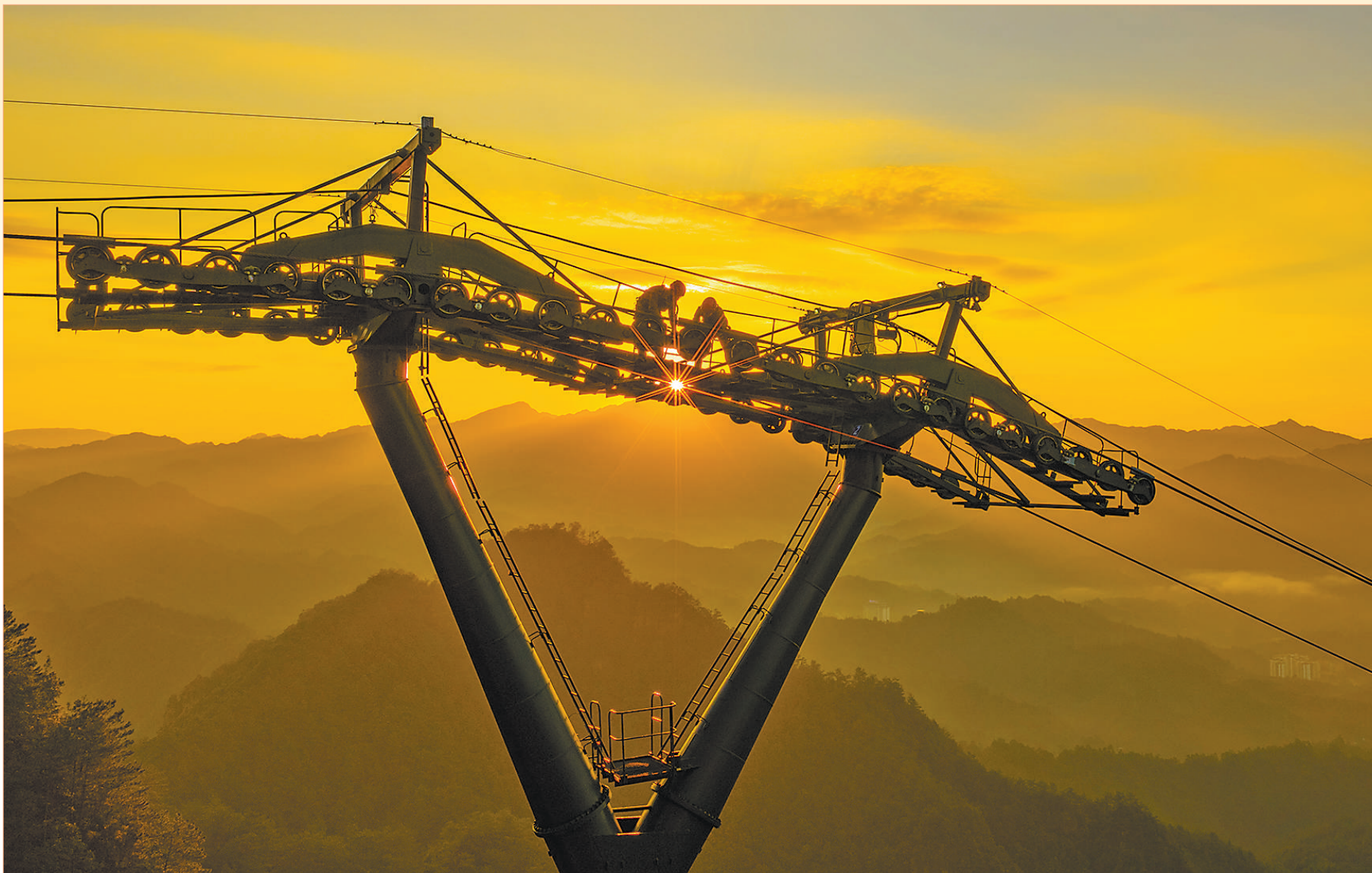
▲广西来宾金秀瑶族自治县大瑶山盘王界景区,工作人员在索道支架上检修设备。
