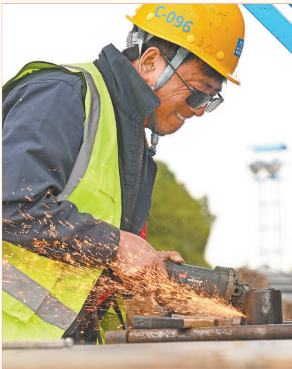
北京地铁12号线田村停车场综合利用项目施工现场,工人正在打磨器件。 本报记者 雷 声 摄
